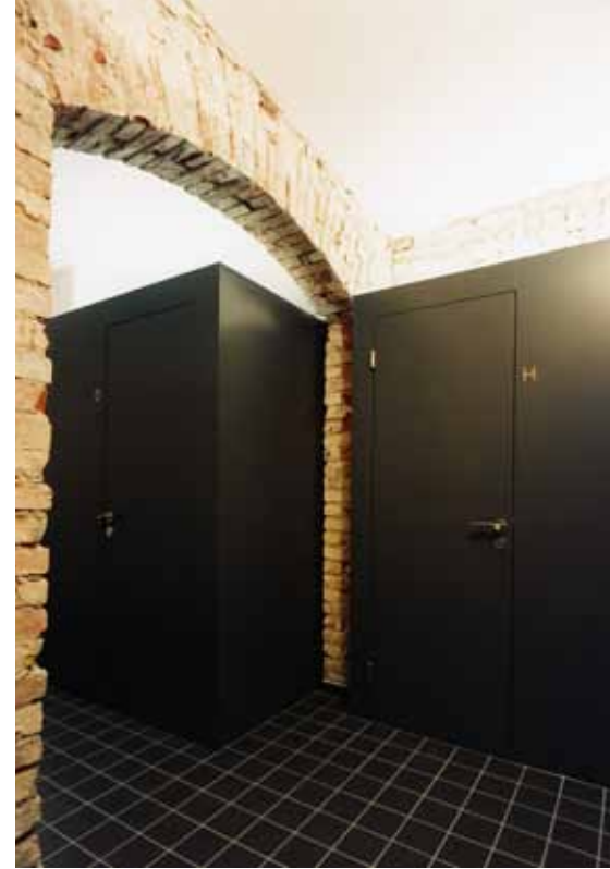
links: Fuge zwischen Hauptgebäude und Terrassenanbau
