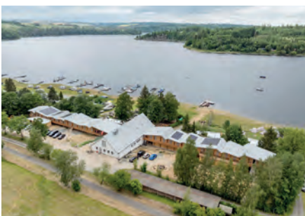
Seesport- und erlebnispädagogisches Zentrum in Saalburg-Ebersdorf von Ludloff Ludloff Architekten GmbH, Berlin, Foto: Thomas Müller
