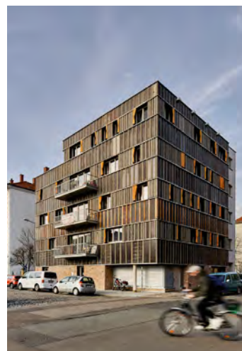
Clusterwohnen und -arbeiten hinter wiederverwendeter Fassade von ASUNA, Leipzig, © Peter Eichler | ASUNA
