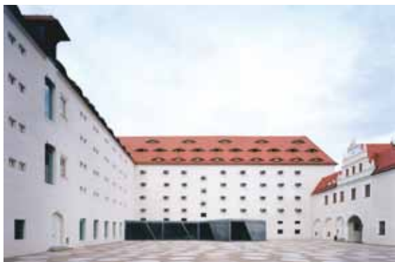
Schloss Freudenstein, Freiberg, AFF Architekten, Ingenieurbüro Dr. Krämer GmbH, Bauherr: Stadt Freiberg
