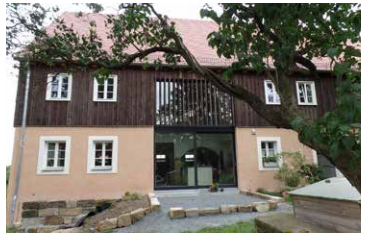
Sanierung und Umbau eines Wohnstallhauses, Gemeinde Struppen, Landkreis Sächsische Schweiz - Osterzgebirge (Foto: LfULG/Kunz)
