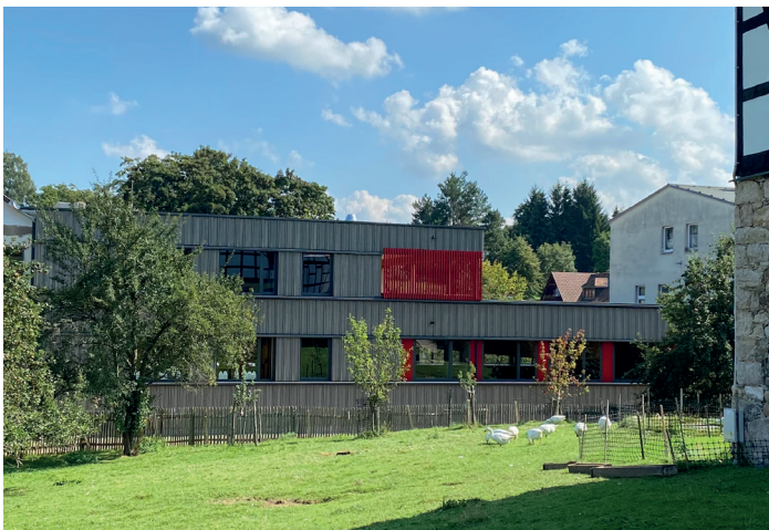
In der Kategorie Öffentliche Nutzung wird die Modernisierung und Erweiterung der Grundschule in Hauptmannsgrün (Gemeinde Heinsdorfergrund, Vogtlandkreis) mit dem Staatspreis ausgezeichnet. Planung: Neumann Architekten + Generalplaner GmbH, Plauen
