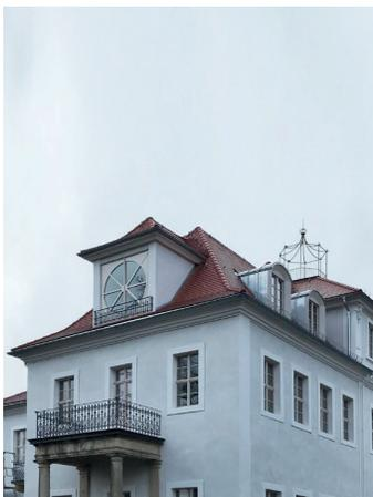
In seiner baukonstruktiven Struktur ist Schloss Prossen vielfältig: der ursprüngliche Baukörper aus Bruchsteinmauerwerk wurde über die Jahrhunderte mehrfach umgebaut, erweitert, aufgestockt; der letzte große Umbau aus dem 19. Jahrhundert hat das Gebäude
