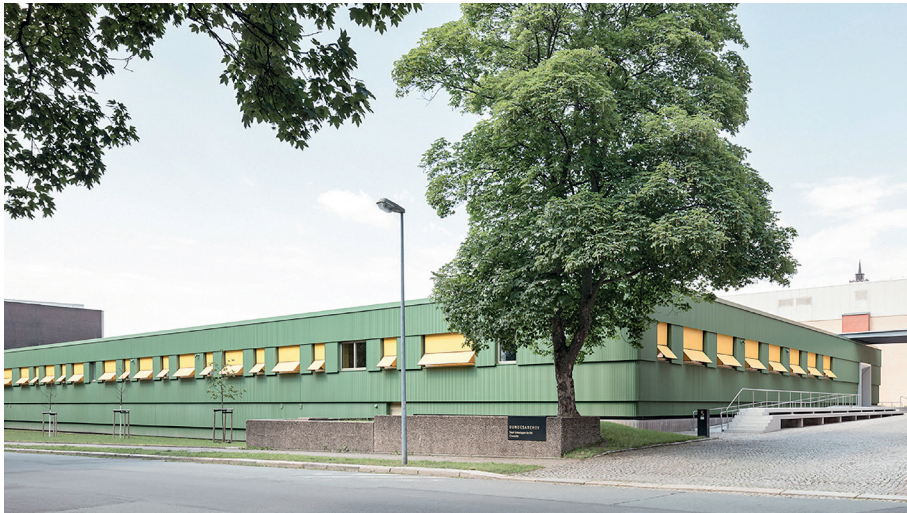
Das Stasi-Unterlagen-Archiv in Chemnitz von Heine Mildner Architekten, Dresden Foto: Till Schuster
