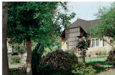
Umbau eines Landhauses in Radebeul (Bauherrschaft: Familie R. & F., Radebeul | Entwurfsverfasser: Summacumfemmer Architekt*innen, Leipzig), Foto: Summacumfemmer
