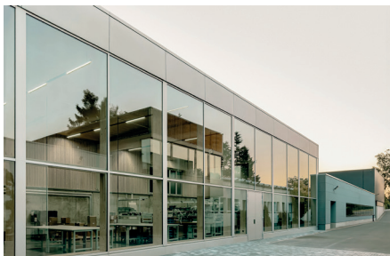
Mühle Shaving in Stützengrün (Bauherrschaft: Mühle Shaving, Hans-Jürgen Müller GmbH & Co.KG, Stützengrün | Entwurfsverfasser: Atelier ST Gesellschaft von Architekten mbH, Leipzig), Foto: Simon Menges
