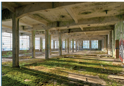
Weiberei Dressler & Marx in Berthelsdorf/Herrnhut, Architekt: unbekannt, Foto: Gunter Binsack
