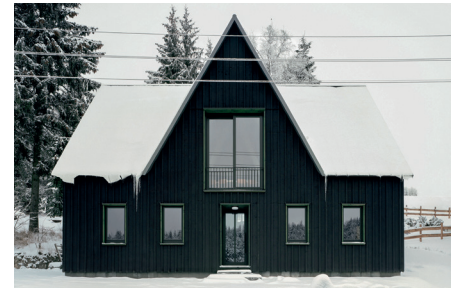
Waldhaus Tellerhäuser, Breitenbrunn (Bauherrschaft: Matthias Voigt, Leipzig | Entwurfsverfasser: Büro Voigt, Florian Voigt, Leipzig), Foto: Hans-Christian Schink
